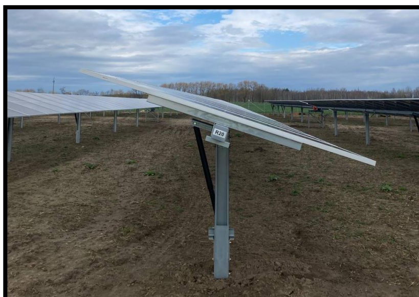
Zdjęcie 3 Sposób montażu tracker
