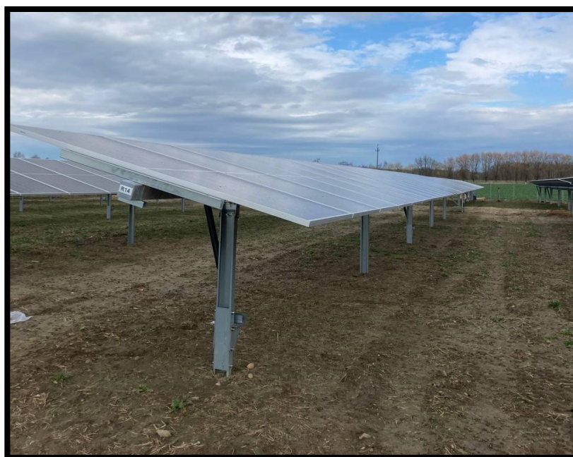
Zdjęcie 3 Sposób montażu tracker
