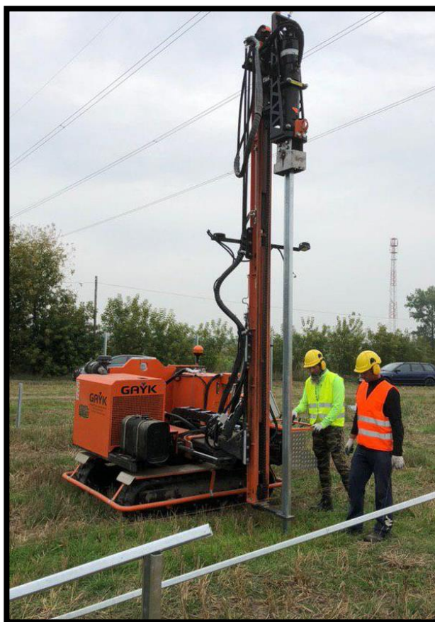
Zdjęcie 7 Montaż konstrukcji wsporczej (kafar)
