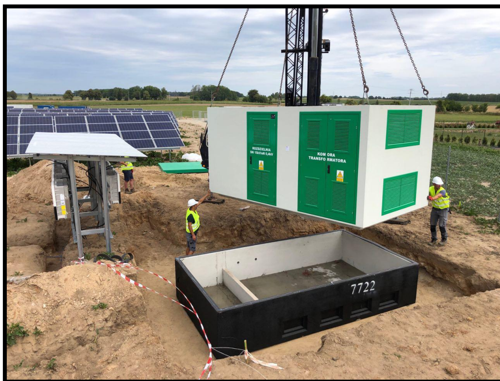
Zdjęcie 8 Posadowienie stacji transformatorowej
