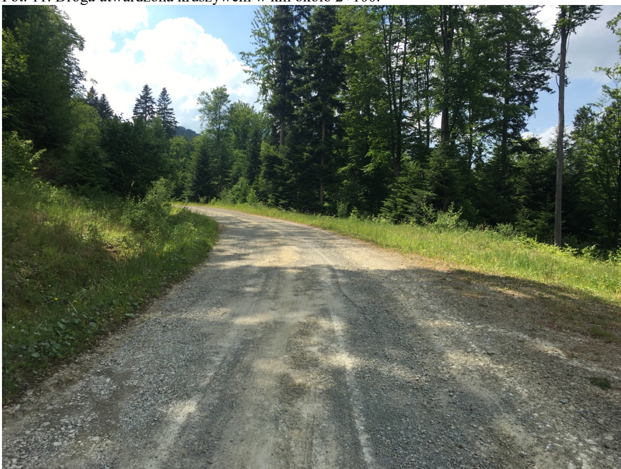
Fot. 12. Droga utwardzona kruszywem w km około 2+400.
