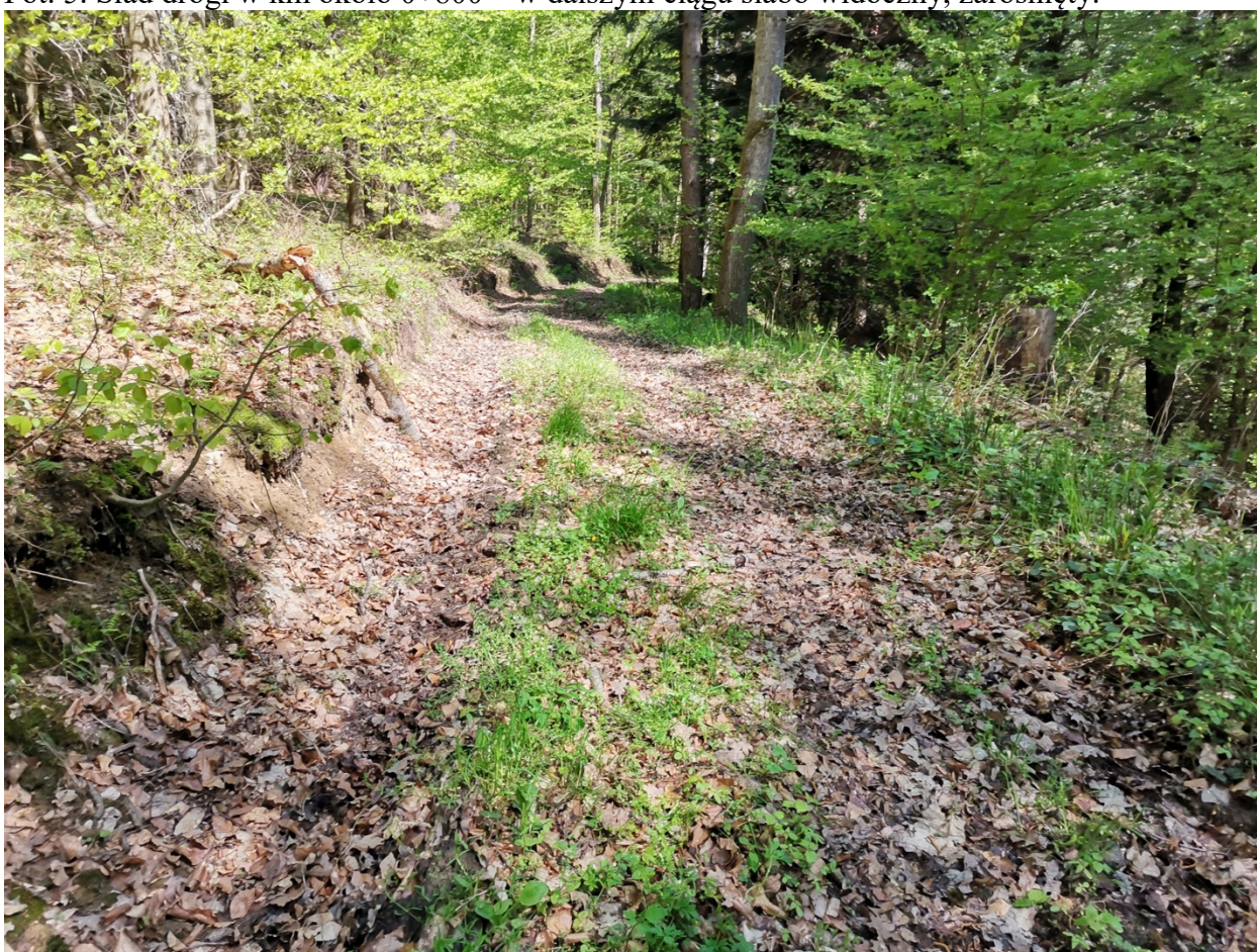
Fot. 6. Szlak zrywkowy w km około 1+000 – znowu zaczyna się bardziej wykorzystywany odcinek.
