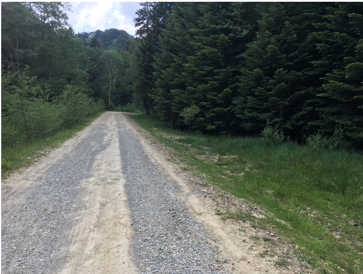
Fot. 11. Droga utwardzona kruszywem w km około 2+100.
