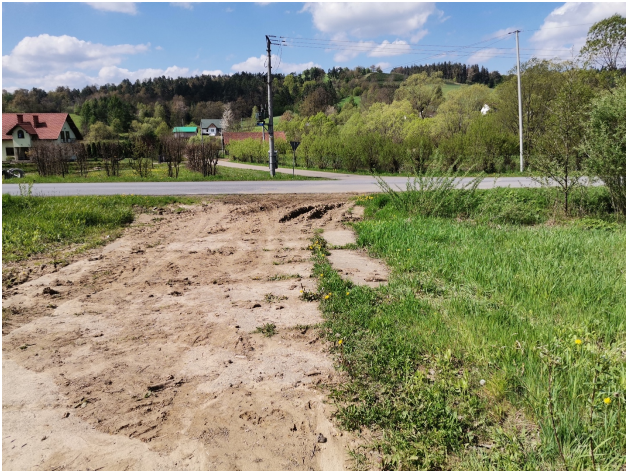
Fot. 1. Początek drogi w km 0+000.
