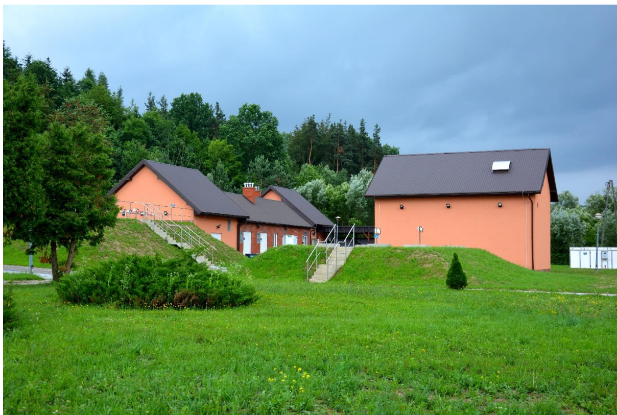
Zdjęcie 1. Oczyszczalnia ścieków w Birczy po rozbudowie i modernizacji.
